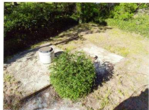
Végétation doublant le muret de protection du P.P.I.
