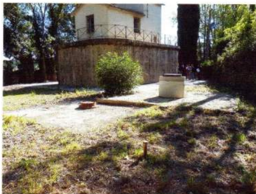
Piézomètre P2, forage SPM01, forage d'exploitation <0 et forage d'exploitation
